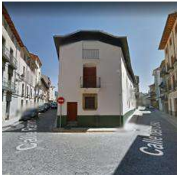
Casa Don Valero, Calle Ramiro I JACA
